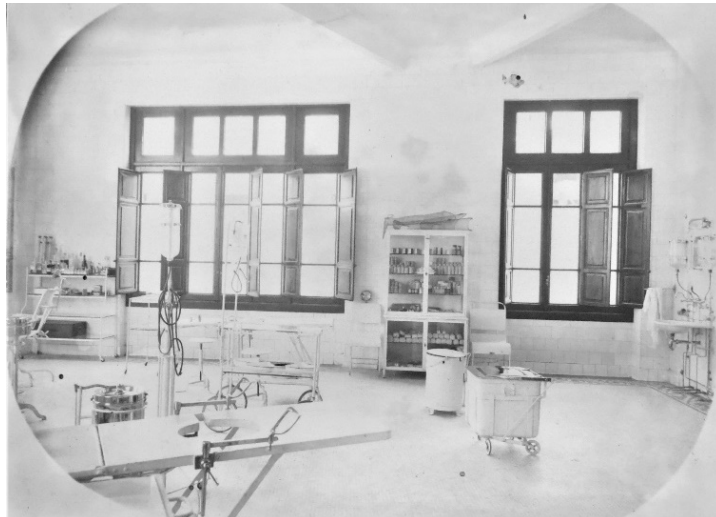
Figura 13 – Sala de Operações – Assistência Pública.
