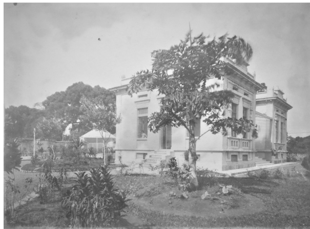
Figura 21 – Edifício antirrábico – Instituto Oswaldo Cruz da Bahia.
