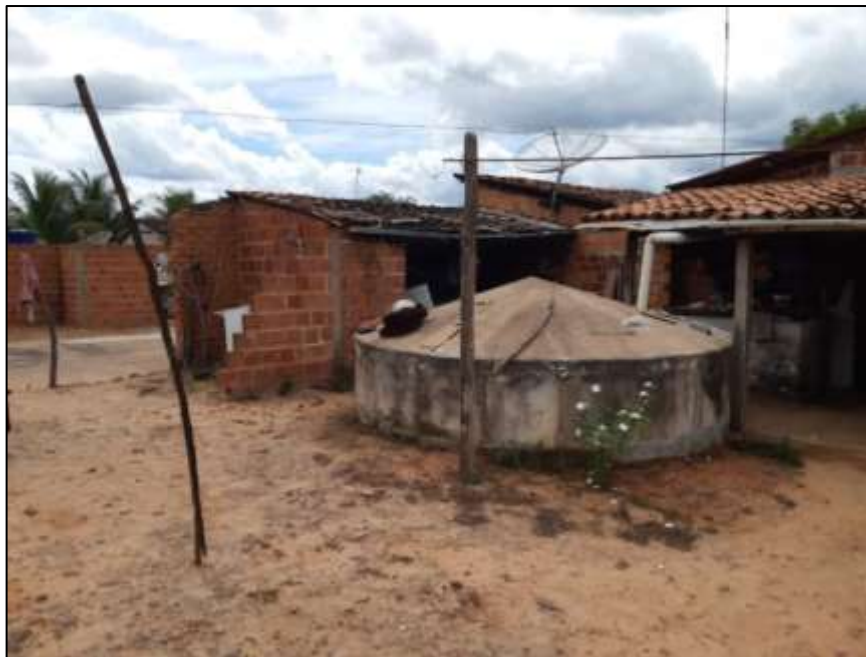
Figura 5 - Cisterna em área sem abastecimento de água no setor 28
