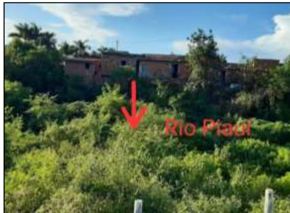
Figura 4 - Domicílios improvisados construídos em área de risco no setor 17
