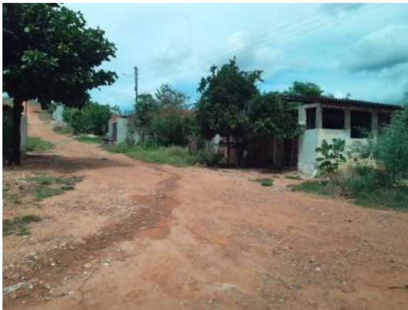
Figura 2 - Falta de infraestrutura urbana no Bairro Caruaru, setor censitário n. 10.
