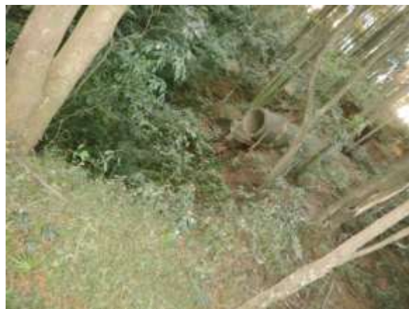
Figura 5: Galeria pluvial no trecho fluvial II – Fonte: Fotos dos autores (2015).
