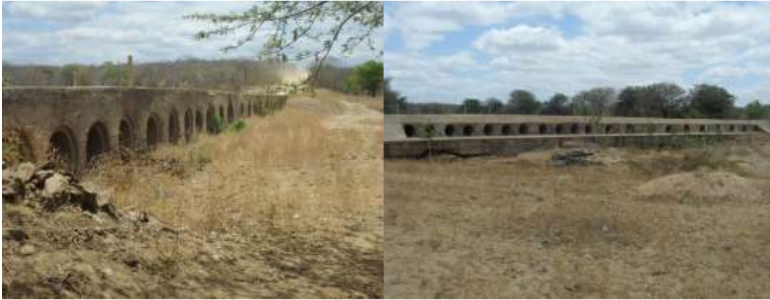
Figura 5. Ponte sobre o Rio Canindé. Direção à Montante e Jusante respectivamente.
