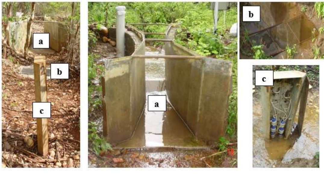
Figura 4– Calha Parshall (a), fosso para coleta de sedimento de arraste (b) e torre de coleta de sedimentos suspensos (c)
