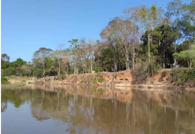
Figura 04 – Aspectos do canal principal
