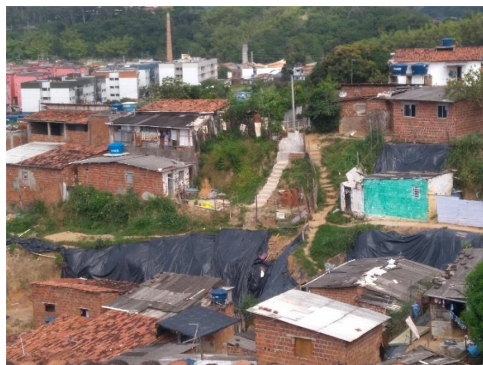
Figura 10: Foto de encostas ocupadas por moradias no bairro da macaxeira
