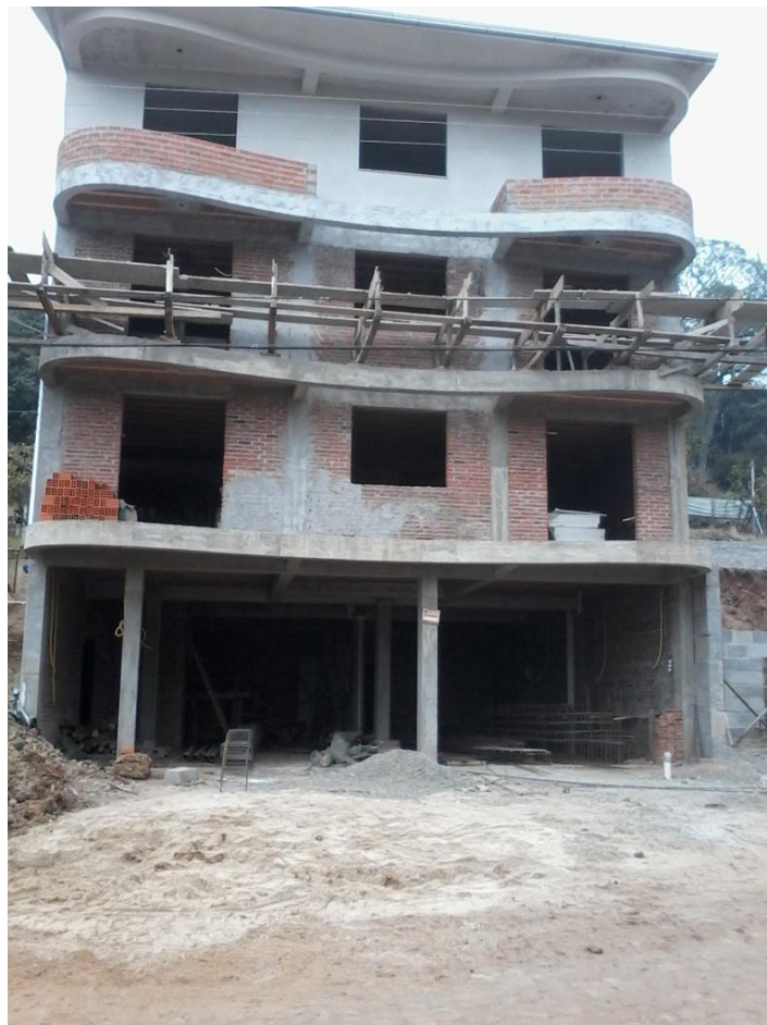
Figura 3 – Construção de prédios no espaço urbano novapalmense
