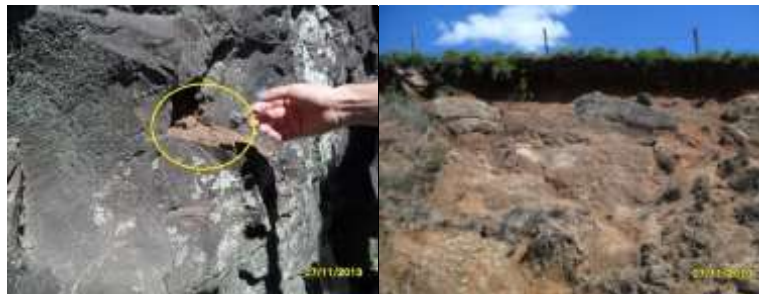
Figura 2 - Meteorização de rocha básica a partir das diaclases (à esquerda), Afloramento de rocha ácida altamente resistente à erosão (à direita).
