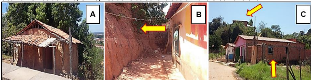
Figura 4 - Áreas de risco no bairro Cangalheiro. Em A, Residência construída com mão de obra não especializada e em ribanceira na rua do Mangueirão; em B, Residência que já sofreu com deslizamentos de terra; em C, Residências construídas em alto e baixo relevo
