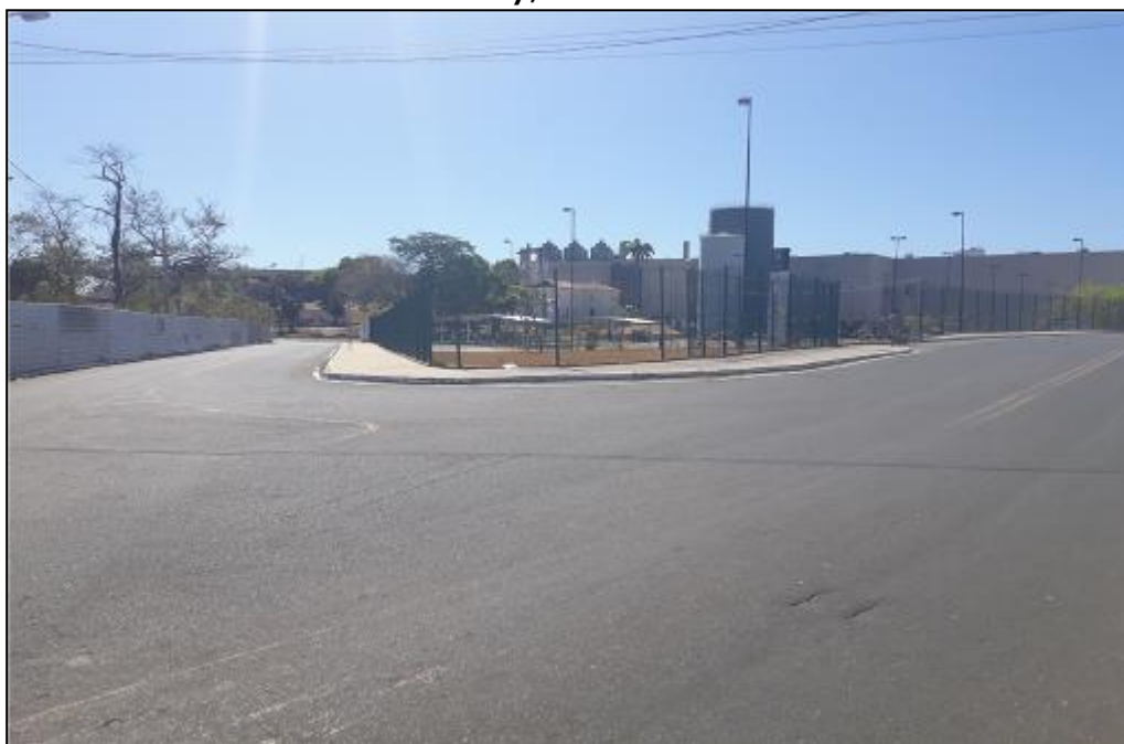
Figura 3 – Fotografia mostrando a pavimentação asfáltica na área do Shopping Rio Poty, Teresina-PI
