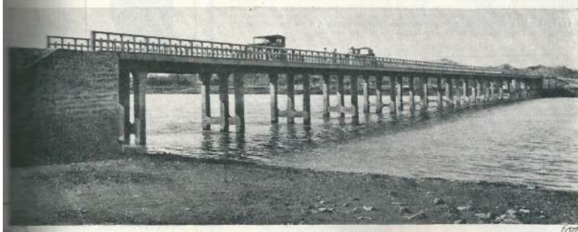
1, 2 e 3. Aspetos da grandiosa ponte, em cimento armado, da estrada de Lourenço Marques a Goba, construída sob a direção do ilustre engenheiro sr. Sá Carneiro.
